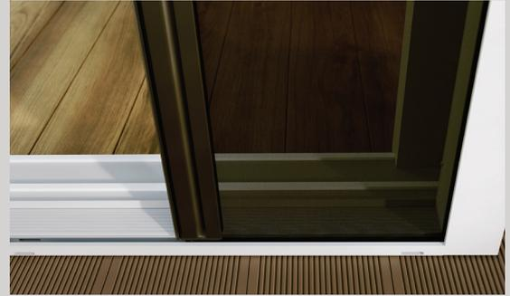
Die 19mm oder 25mm Schwellenhöhe des S2 ist perfekt für die Nachrüstung oder den Neubau geeignet und ermöglicht eine einfache, bodengleiche Montage.
